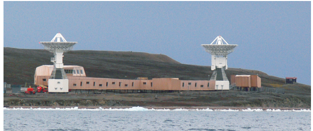
建設中の新アンテナ基地 (写真: 榎本)
