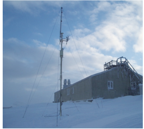
ラベン基地に設置された低周波電波観測装置・モノポールアンテナ（写真：土屋）
