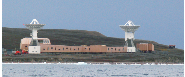
建設中の新アンテナ基地 (写真: 榎本)
