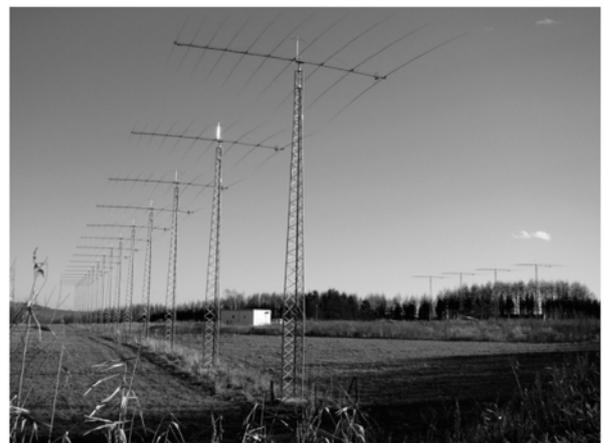
図 2 北海道-陸別 SuperDARN レーダーの送受信用ログペリアンテナ
