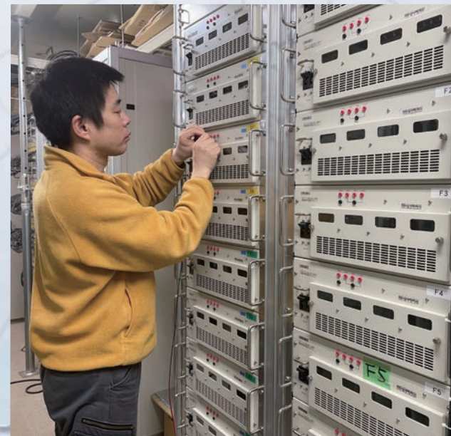
PANSYレーダー屋内装置の点検作業
