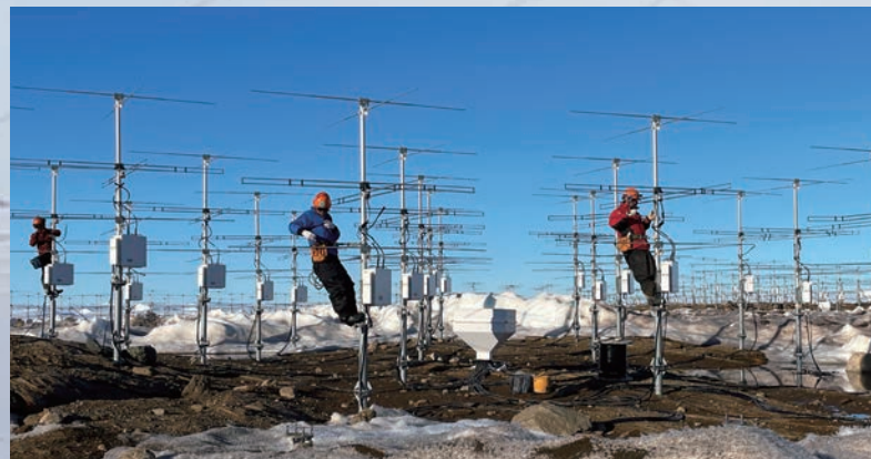
PANSYレーダーのアンテナ保守作業
