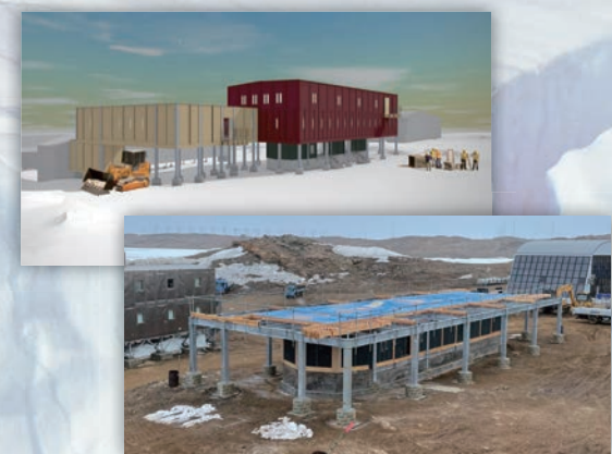
(上) 新夏期隊員宿舎のパース (下) 第65次施工の1期工事完成写真
