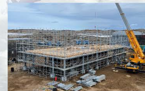
2階の工事スタートの様子
