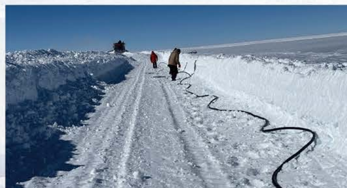
電源ケーブル敷設
