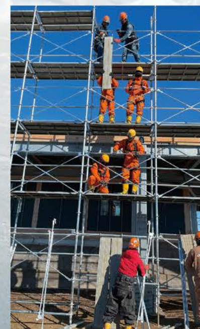
第66次では3階床高さまでの足場を組み、工事を実施
