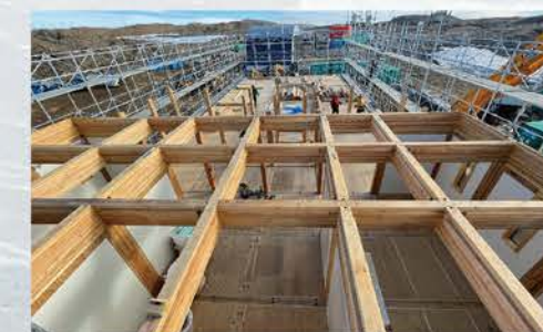
2階の柱、壁パネル、梁を組み立てている様子
