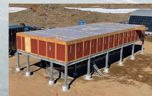
第66次で2階までの工事が完了
