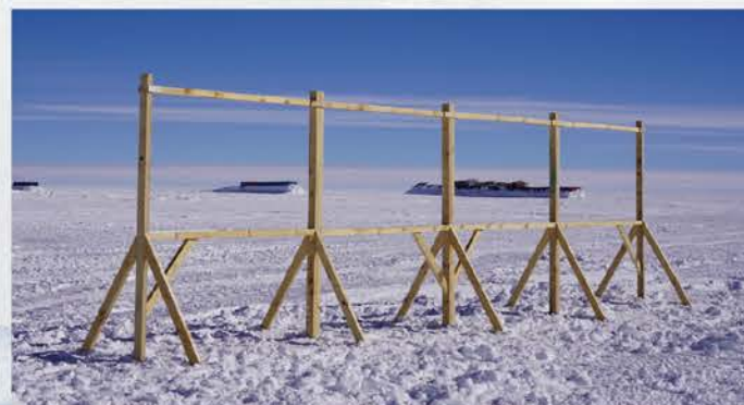
ソーラーパネルの台
