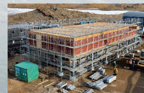
3階の床パネルを組立、第66次夏工事は終了
