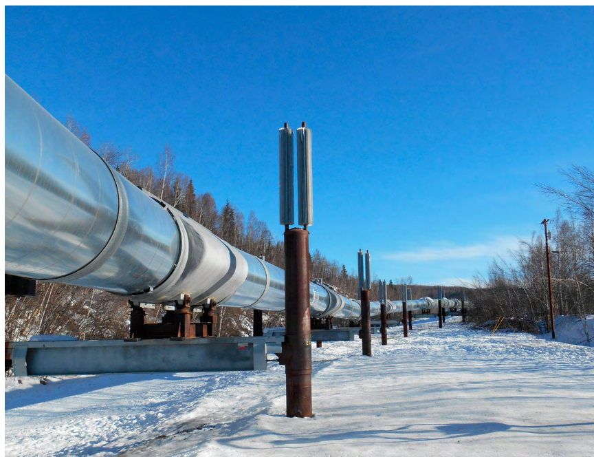
アラスカのパイプライン
