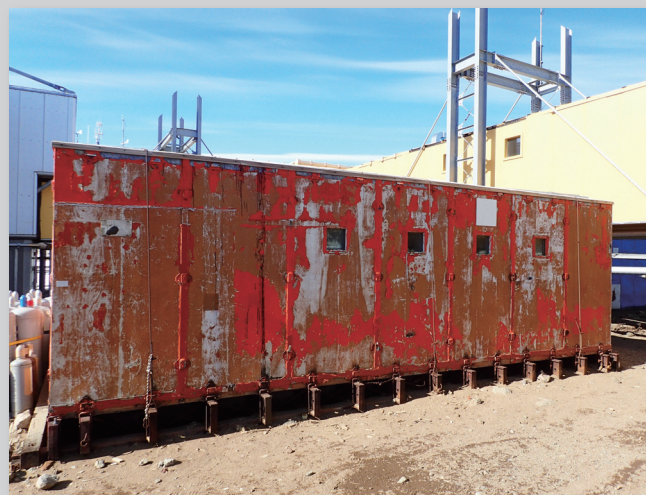
第1次隊主屋棟保存工事に向けた調査
