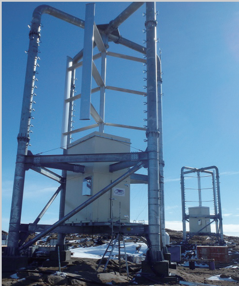
風力発電装置3号機建設
