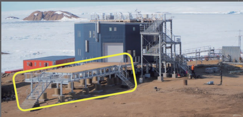
完成した基本観測棟 黄枠内が61次で建設した放球デッキ
