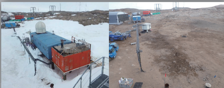
解体前の気象棟（左）と解体後の様子（右）
