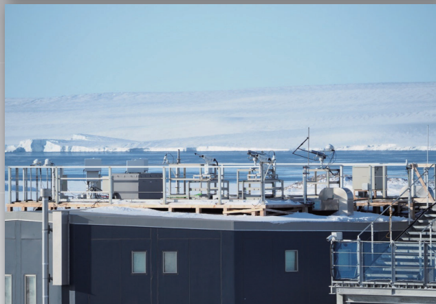
基本観測棟屋上デッキ 屋上には様々な観測機器を設置しています。
