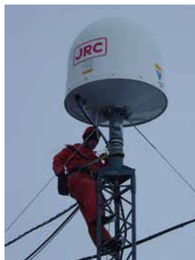
【インマルサット工事】
